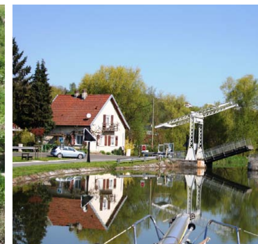
Híd és hídórház
